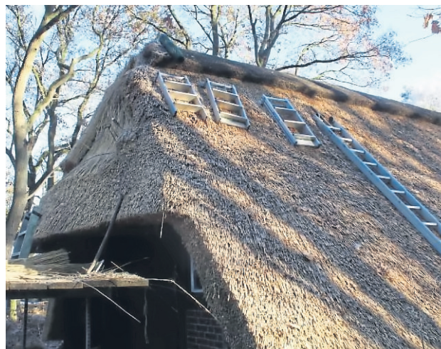
Die Arbeiten sind nahezu abgeschlossen.
